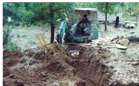
Réalisation des tranchées
