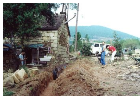
Fond de fouille et tuyaux
