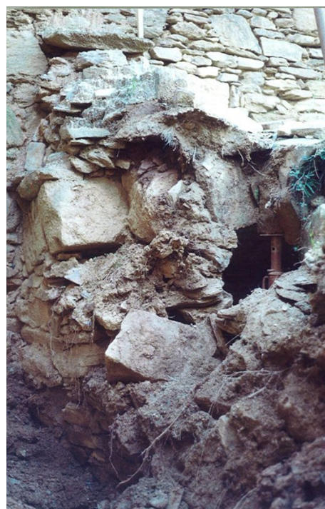
Le mur déblayé et la voûte à reprendre
